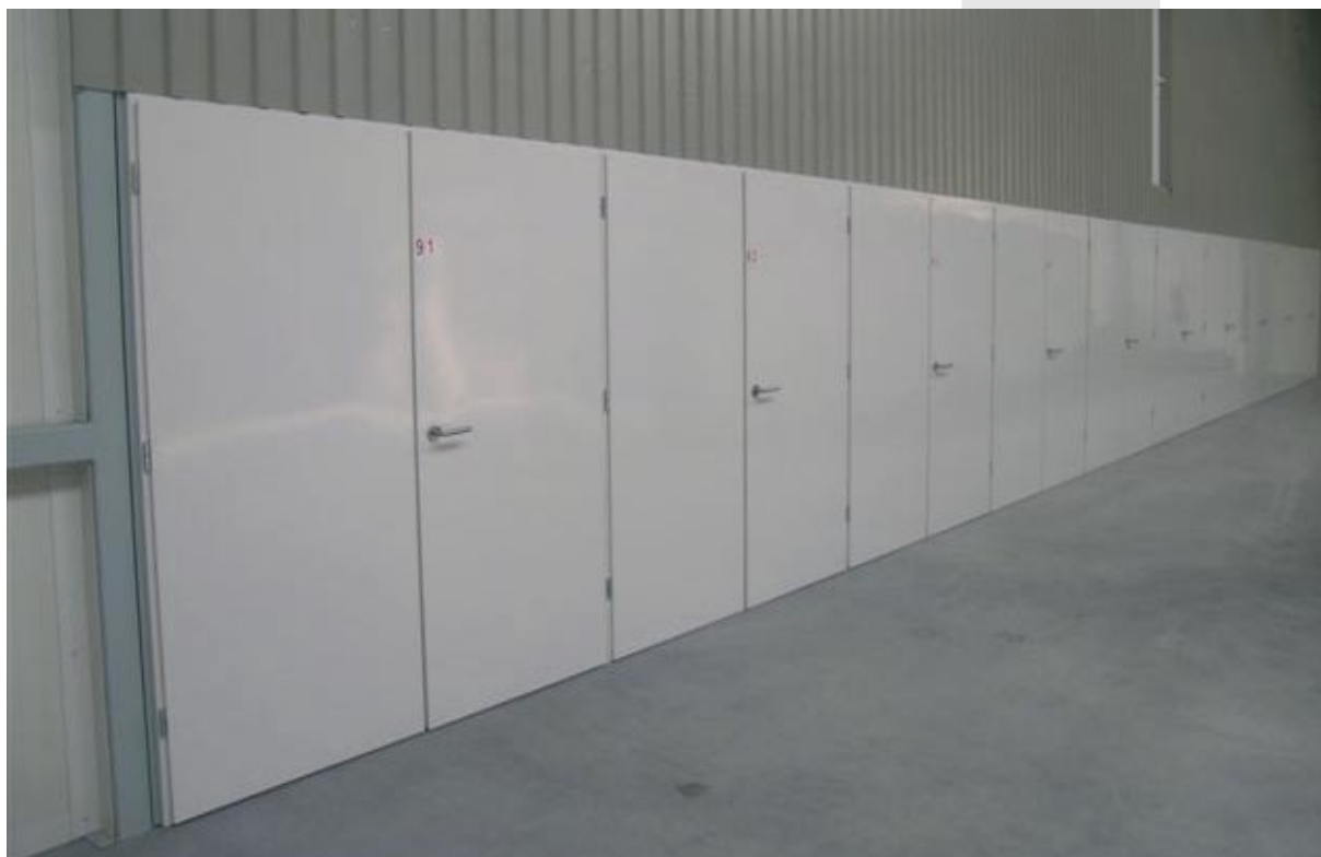
Un tunnel di degasaggio tipico della sterilizzazione con Ossido di Etilene. I tempi di attesa per la quarantena e i rischi ambientali dovuti ai residui e al trattamento stesso, sono i principali svantaggi di questo metodo di sterilizzazione.
